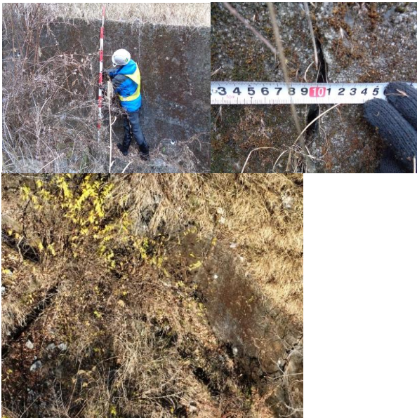
写真-1 白谷沢第二砂防堰堤左岸袖部 人力点検(上) UAVを用いた点検(下)
