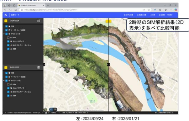
図-4 活用事例 (崖地崩落箇所: 2時期比較)
