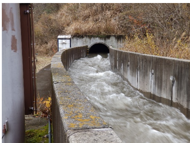
写真-1 道志導水路放流口の放流状況
