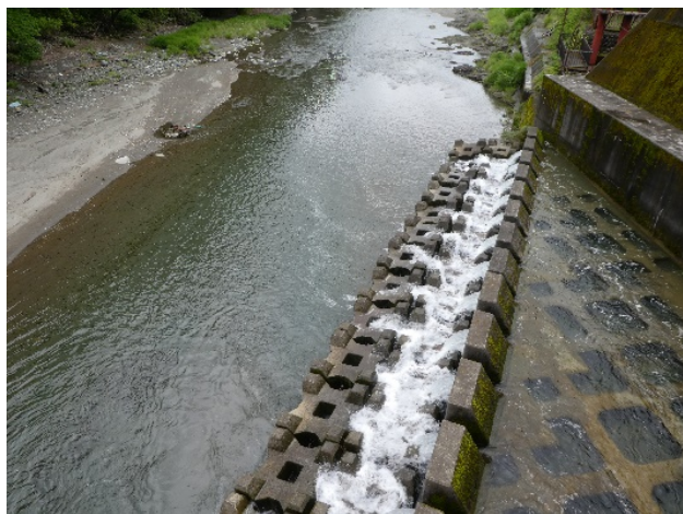
写真-3 津久井導水路放流口の放流状況
