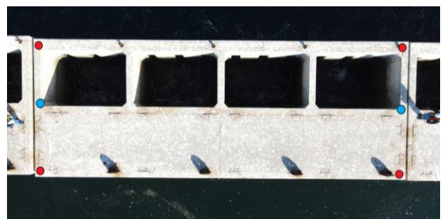
写真-2 スリットケーソンの動態観測測定位置
