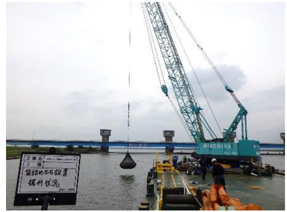
図6 水上における袋詰玉石据付の施工状況
