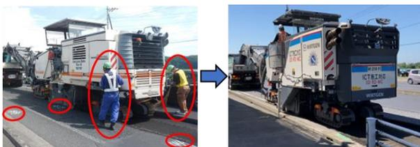
図-2 ICT切削施工による省人力化
