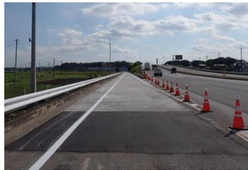
写真-2 施工完了後のコンクリート舗装
