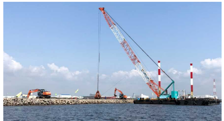
図-6 実際の施工状況
