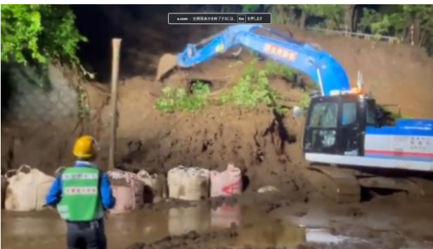
図-3 遠隔操作式バックホウによる施工
