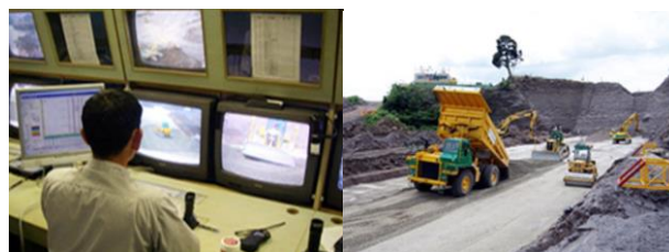
図-1 安全な操作室からの遠隔施工
