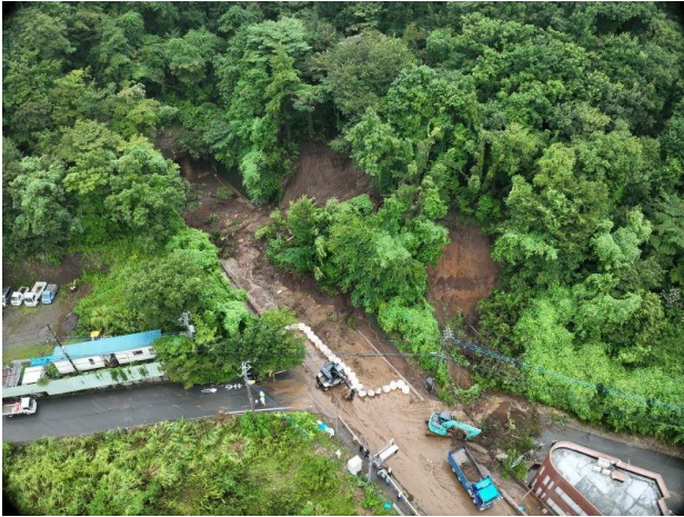
図-2 被災箇所（全景）
