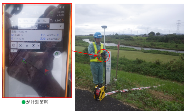
写真-2 ローバーによる座標確認
