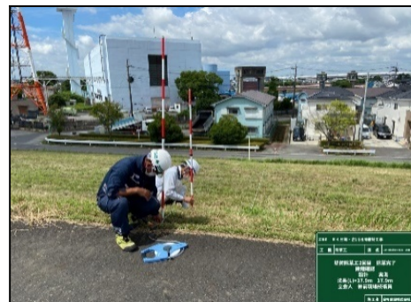
写真-1 出来形確認の様子
