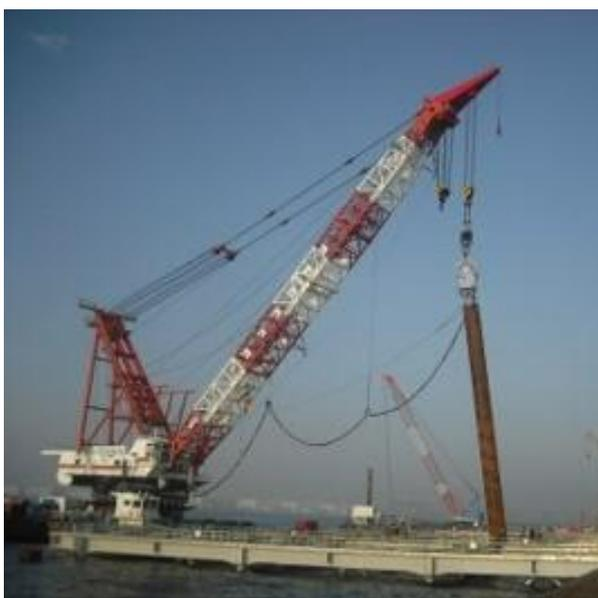
図-5 パイプロハンマによる斜杭打設の様子
