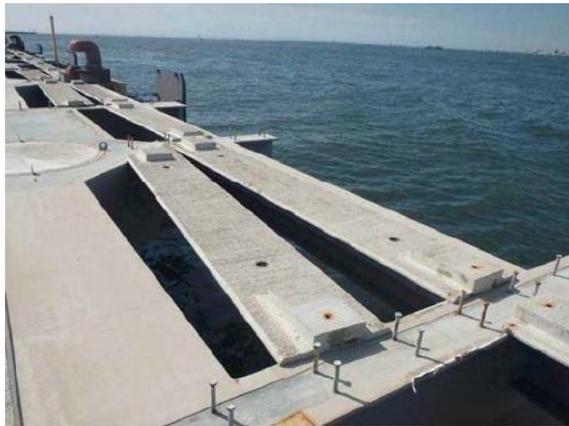
図-8 プレキャスト型枠被災の様子
