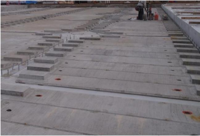
図-6 プレキャスト底型枠設置の様子
