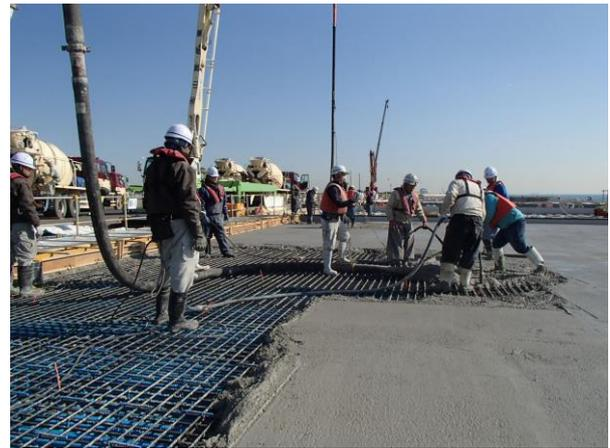
図-7 現場打ちコンクリート打設の様子
