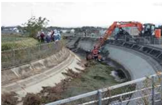
写真-2 土砂撤去状況
