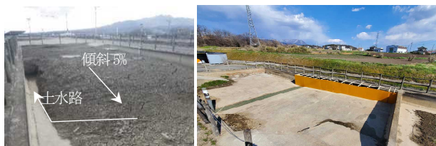
写真4 土水路試行 写真5 コンパネ水路試行
