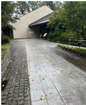
写真-9 改修後のアプローチ
