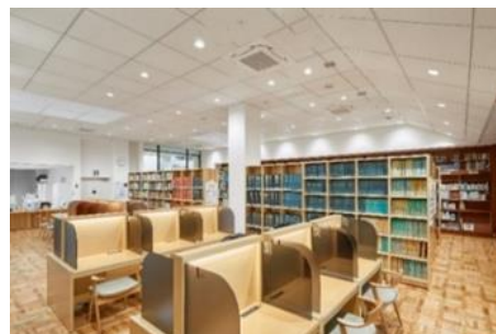
写真-7 書架と軽量天井
