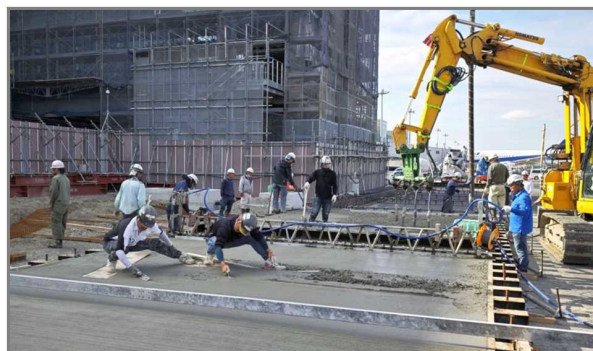
写真-2 多くの職人による人力打設
