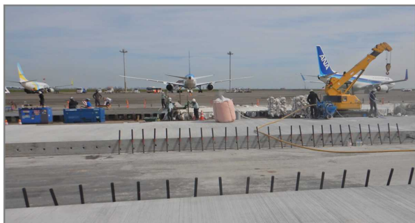
写真-1 航空機運用範囲と近接する施工箇所
