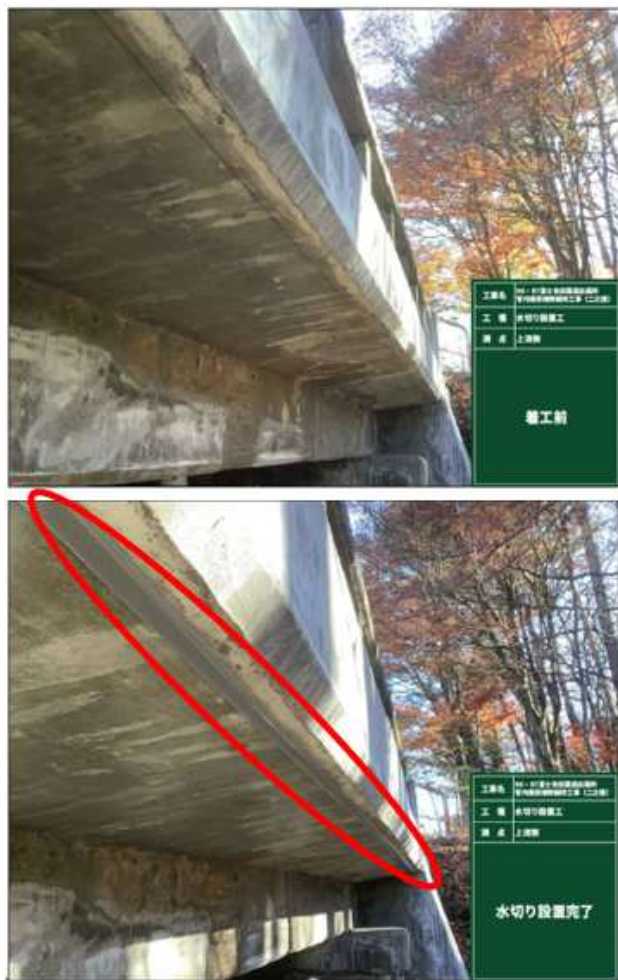
写真-5 水切り設置状況
