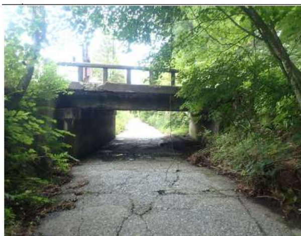
写真-2 側面全景
