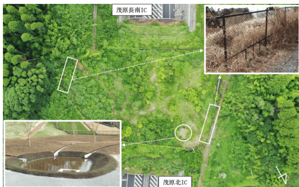
写真2 どうぶつのはしの池と出入口
