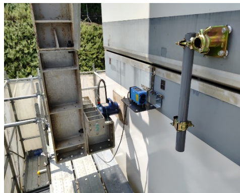
（写真-4）横梁固定設備及びモニタリング設備
