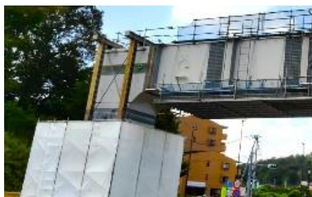
（写真-3）P13橋脚横梁固定設備外観
