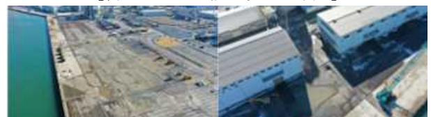
【ドローンによる被災状況の確認】
