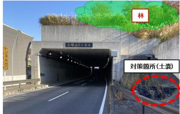
図-9 小塚山トンネル上部の林および土嚢対策状況
