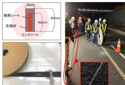
図-3 発熱シート構造と敷設状況
