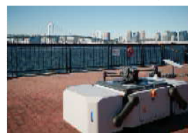
c) DJI Dockの設置状況
