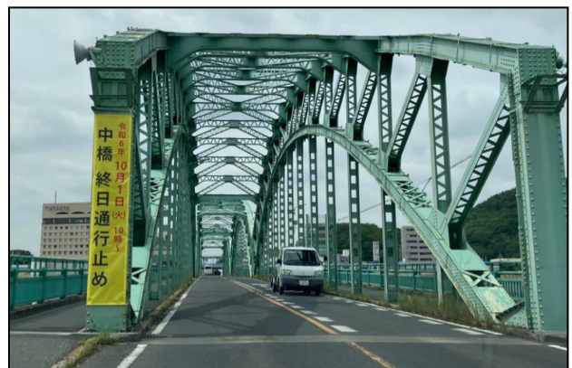
写真-2 対策状況写真
