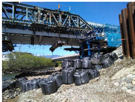
図-9 吊上げ設備による支持
