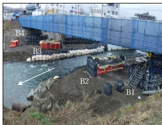
図-5 ベント基礎復旧作業状況（4月3日）
