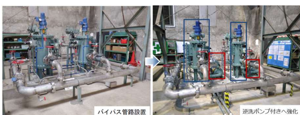
写真5 暫定対策（逆洗機能付きへ機能向上）
