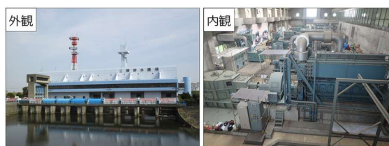
写真1 三郷排水機場の外観・内観
