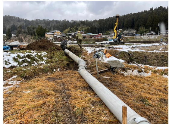
写真-3 仮設配管の布設例（珠洲市宝立浄水場）
