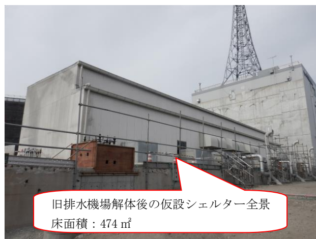
図-8 仮設シェルター
