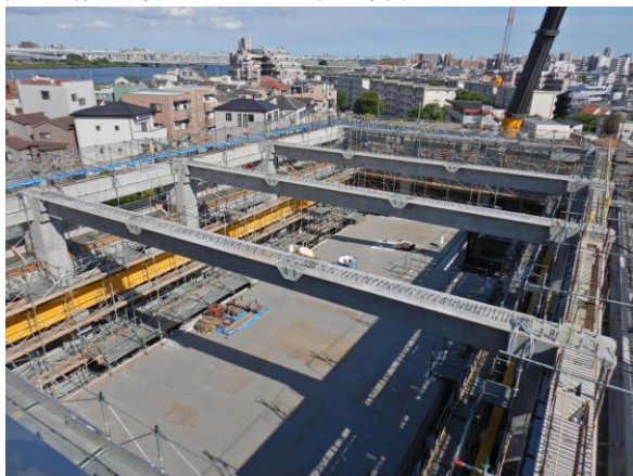
図-11 部材設置状況
