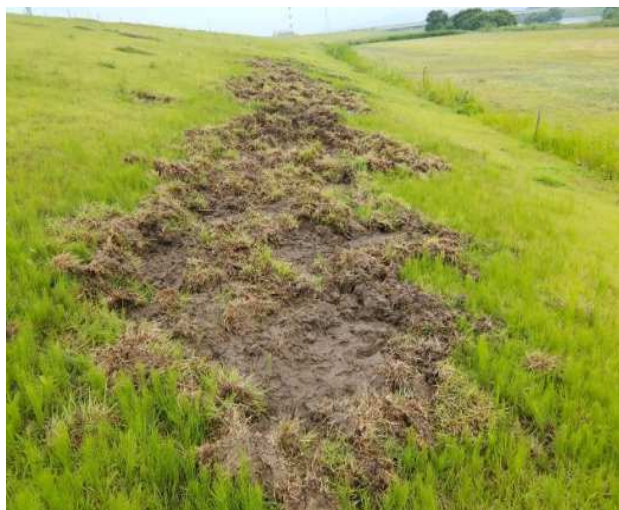
写真-1 イノシシによって掘り返された河川堤防
