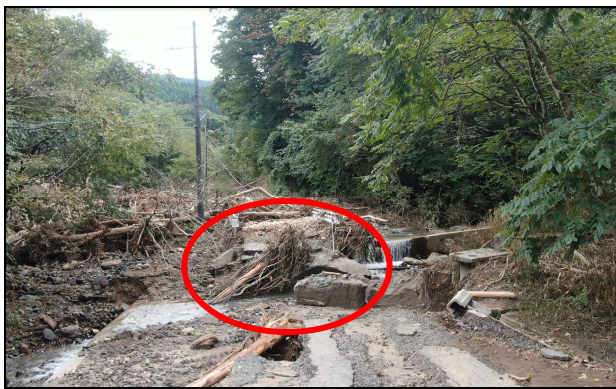
図-5 離陸箇所から見た状況
