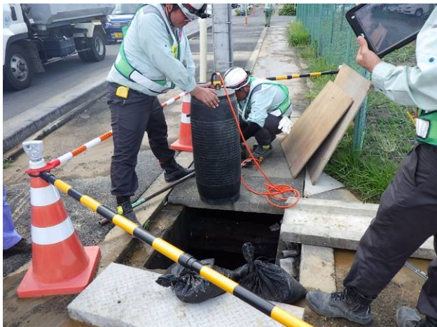
写真-5 止水バルーン設置作業
