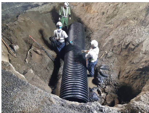
写真-7 管布設作業
