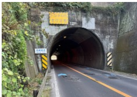
写真-2 高崎トンネル坑口(終点側)
