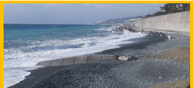
第4岩盤型潜水突堤 (2025(R7)年1月時点)
