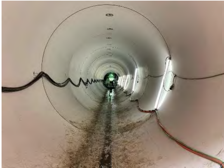
【我孫子市 柴崎雨水幹線整備】
