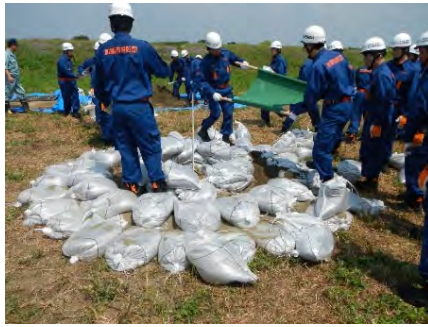
漏水防止工法（釜段工）の訓練状況
