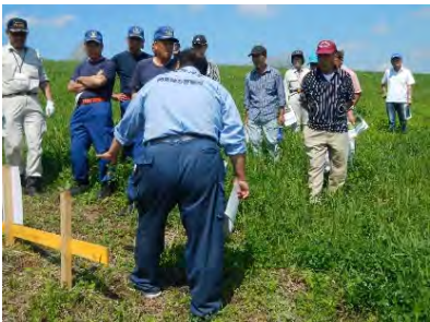
徒歩による堤防の点検
