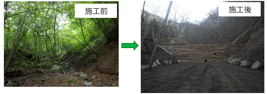
溪間工（荒廃溪流の復旧工事：コンクリート谷止工） 施工地：渋川市
