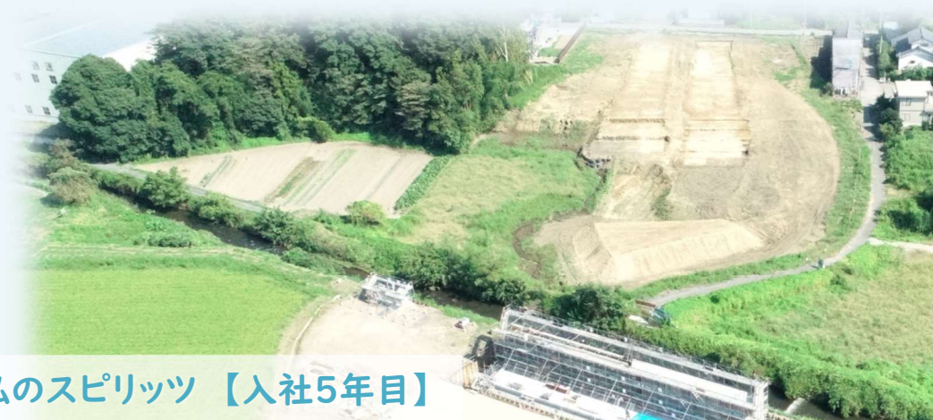
本線橋 AI橋台 底版打設状況
