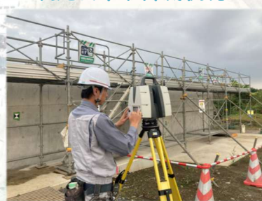
地上レーザスキャナを用いた 3次元出来形計測状況
