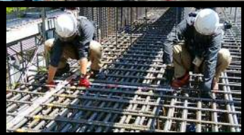
鉄筋組立完了時 (出来形確認状況)
