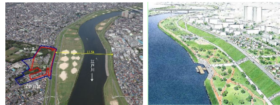
篠崎公園地区高規格堤防整備の実施 （国・東京都・江戸川区） 高規格堤防上面を活用した高台まちづくり
