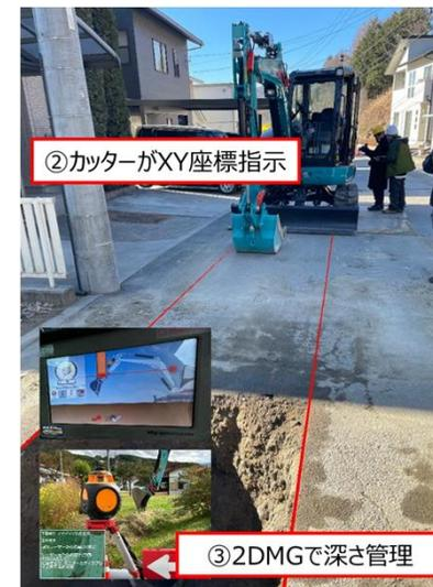
管理設工事において、事前に専門工事業者によるアスファルトカッターでXY(平面)の床掘位置をあらかじめ決め、床掘・管設置におけるZ(深さ・勾配)管理を、2Dマシンガイダンスで実施。
