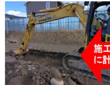
②3D-MG施工 + ②刃先による計測
