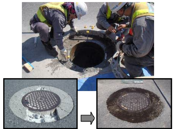
〈マンホール補修〉
