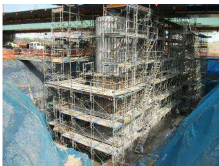
〈コンクリート巻立て施工状況〉
