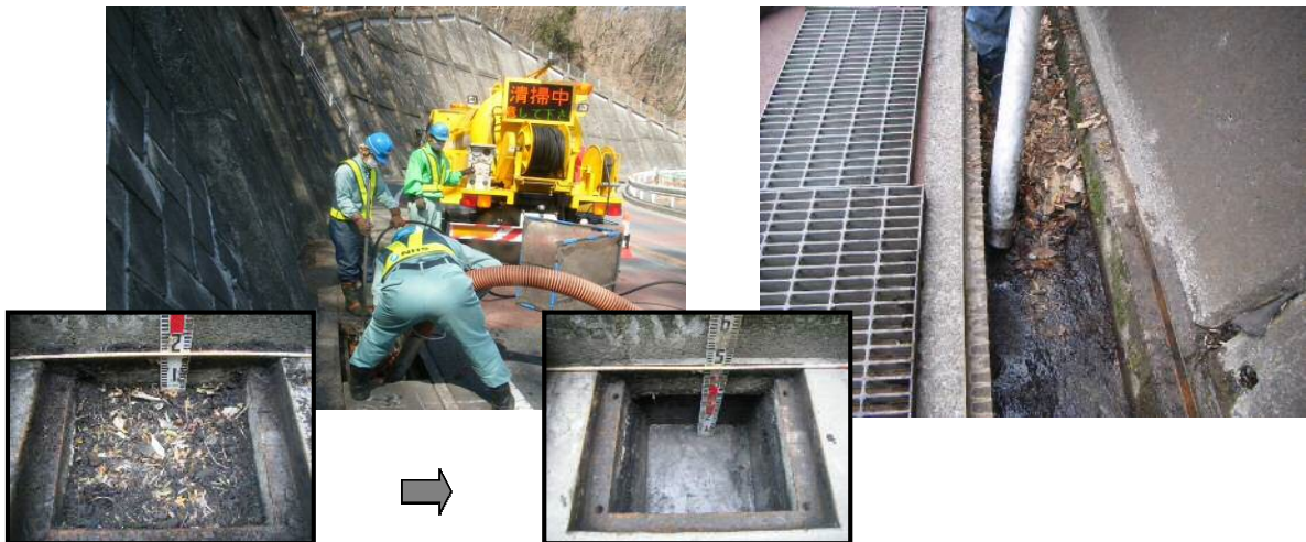
〈側溝清掃（機械）〉
