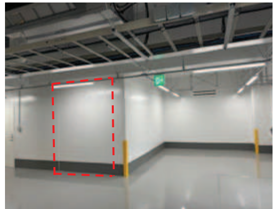
② EVシャフト埋設部
