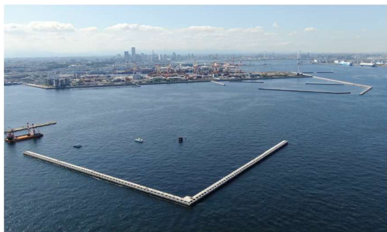
新本牧ふ頭ハイブリットケーソン据付 (令和6年4月)
