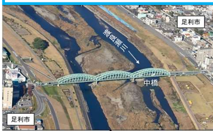
中橋橋梁架替事業
