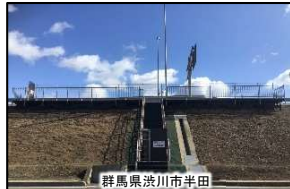
緊急避難施設の整備
