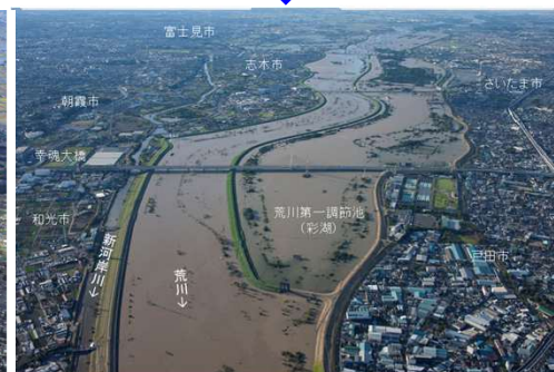
荒川第一調節池
