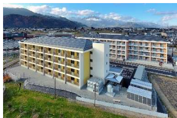
公営住宅整備事業 （長野県）
