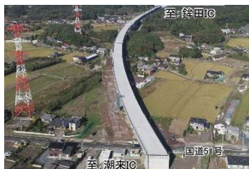
施工状況(小泉高架橋)
