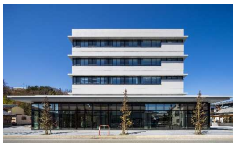
富士川地方合同庁舎
