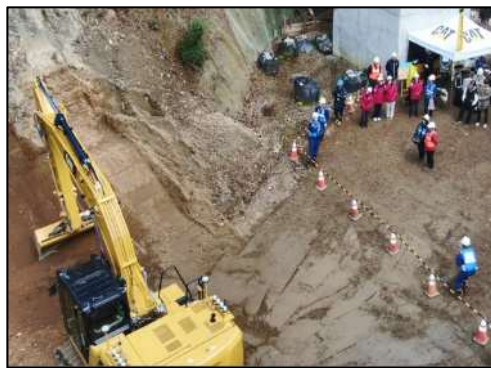
関係機関（建設業界等）との連携訓練
