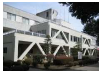
総合運動公園事務所 （栃木県）
