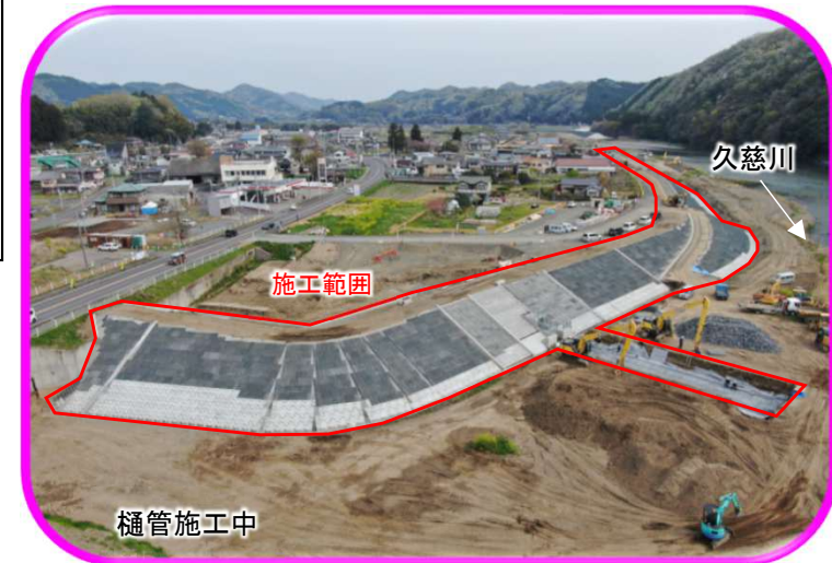
③ 常陸大宮市山方（右岸）地区
