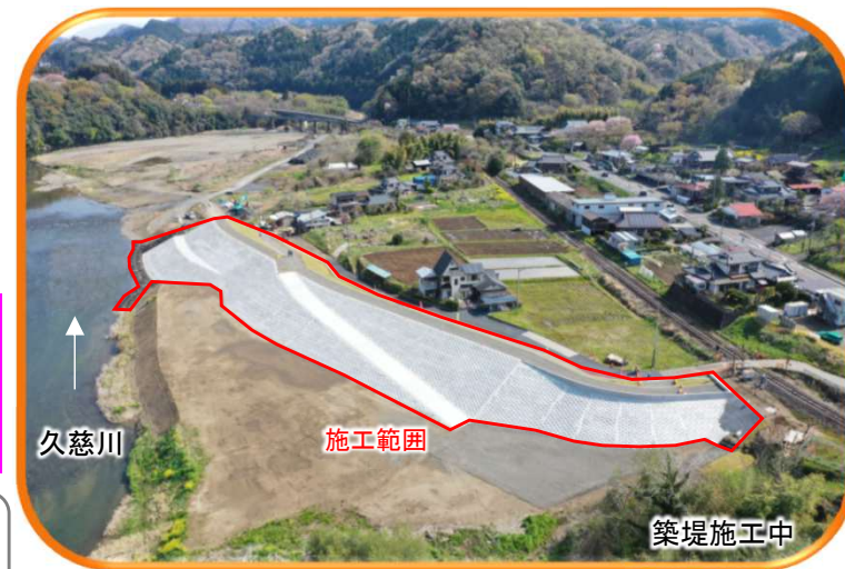
⑨ 大子町頃藤南（左岸）地区
