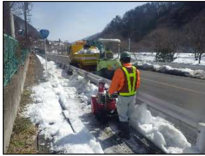
〈歩道 機械除雪〉
