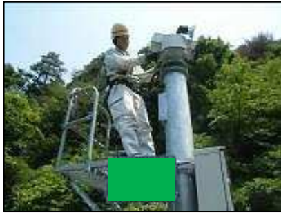
〈CCTV（機能点検）〉
