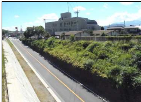
〈除草（法面）実施前〉
