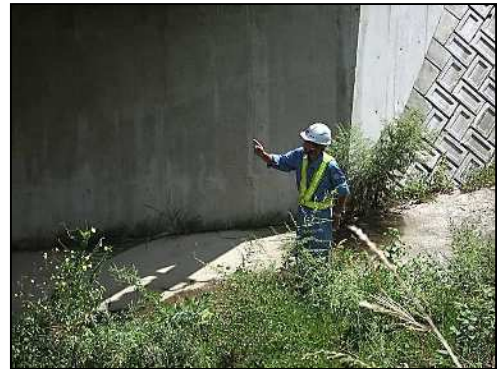
〈道路施設の定期巡回〉
