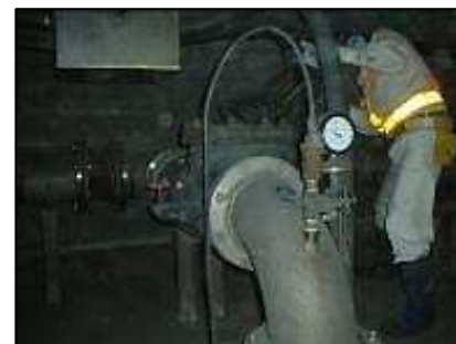
〈道路排水設備（機能点検）〉
