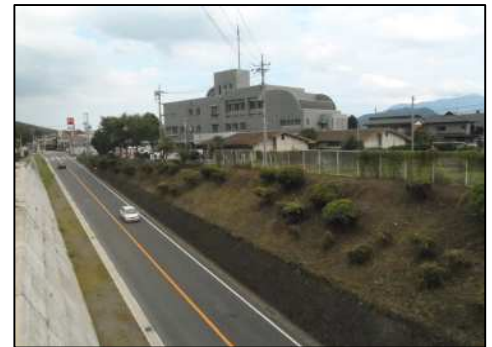
〈除草（法面）実施後〉
