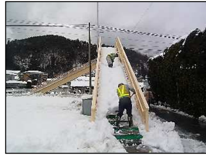
〈歩道橋 人力除雪〉 (小沼歩道橋)
