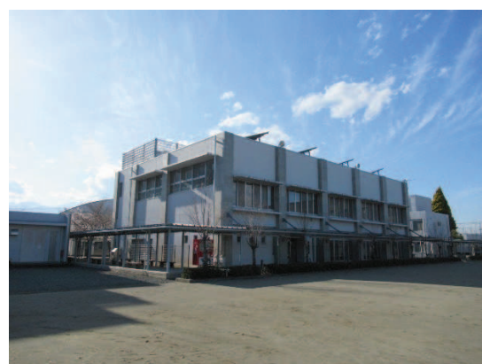
道場・炊食浴棟 外観
