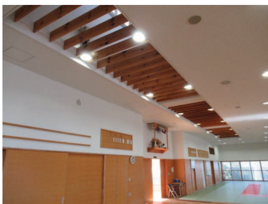
道場室内機設置予定位置
