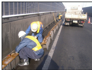
〈側溝清掃（機械）〉
