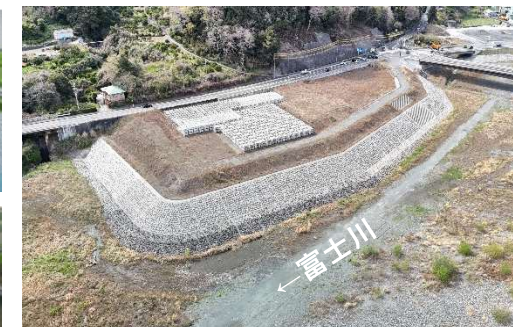
資材備蓄状況(R7.4)
