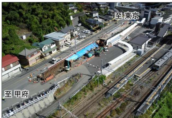
① 施工状況(全景)
