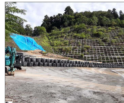
応急復旧工事後（現状）
