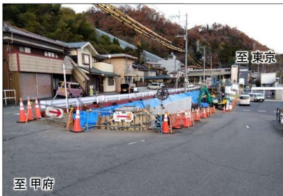
② 施工状況(全景)
