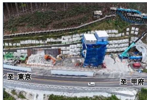
トンネル掘削工事ヤード
