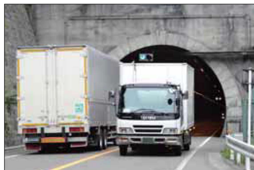
ゆとりのないすれ違い(現トンネル)
