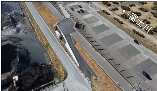
坂路改良の状況
