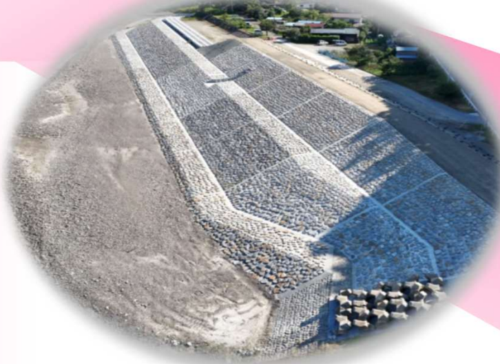
富士川 手打沢地区築堤
