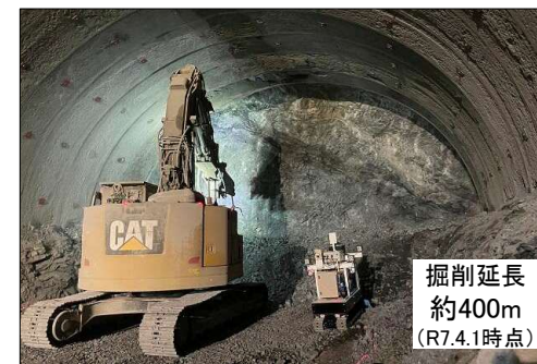
トンネル掘削状況
