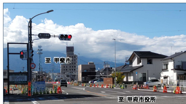
② 工事状況(貢川交番南交差点付近)
