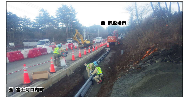
② 工事状況
