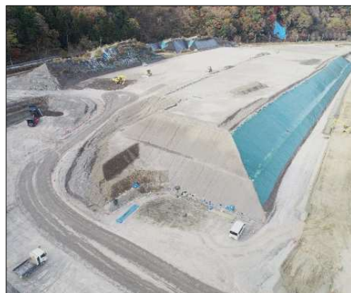
トンネル残土造成工事（粟倉地区）
