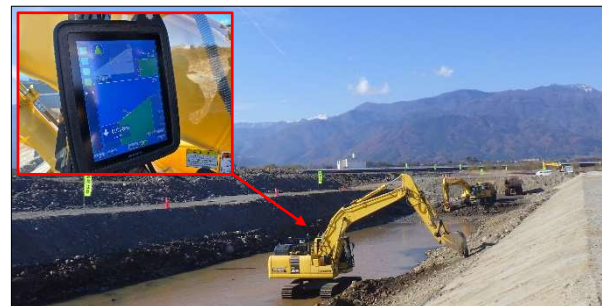
ICT建設機械による掘削（釜無川）
