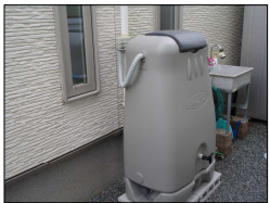
貯留槽の整備事例(富士市)
