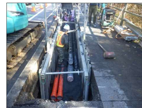
施工状況(鳴沢電線共同溝)
