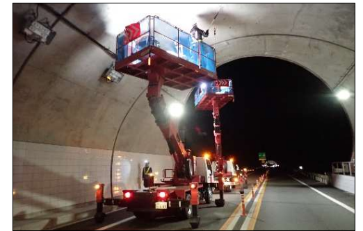
トンネル点検
