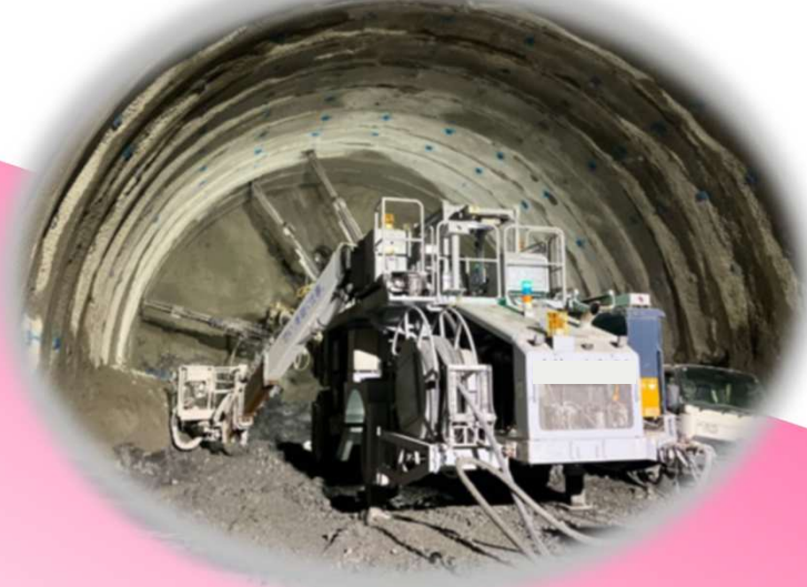
国道20号新笹子トンネル改修
