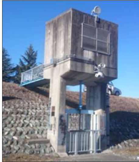
横川排水樋管全景
