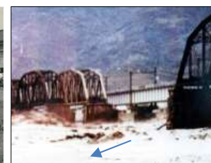
東海道本線鉄橋の流失
