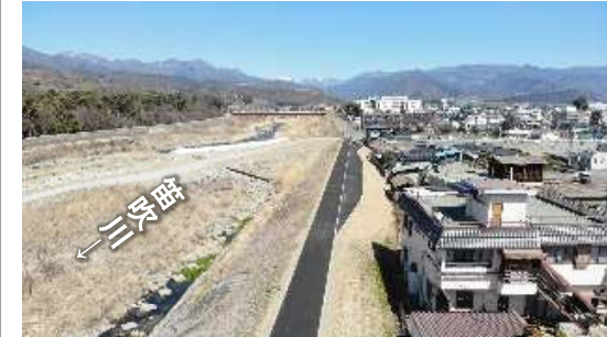
管理用通路の状況
