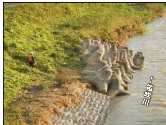
応急復旧後(根固ブロック設置状況)
