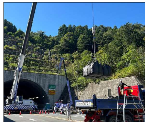
応急復旧工事の状況
