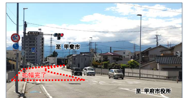
③ 開通状況(貢川端西詰交差点付近)
