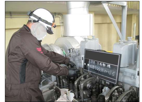
機械設備の点検
