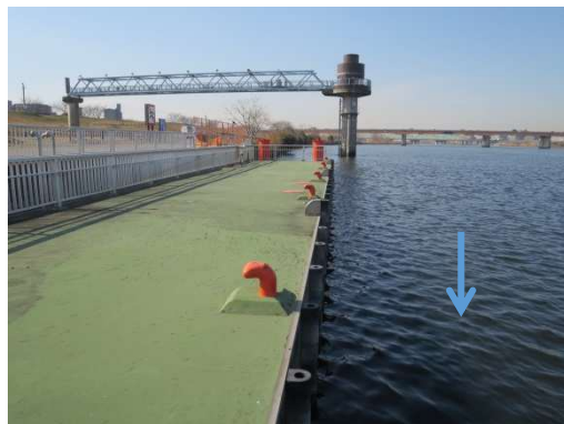
4. 岩淵緊急用船着場
