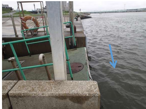
11. 小松川緊急用船着場
