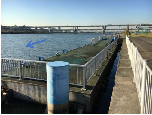
9. 堀切緊急用船着場
