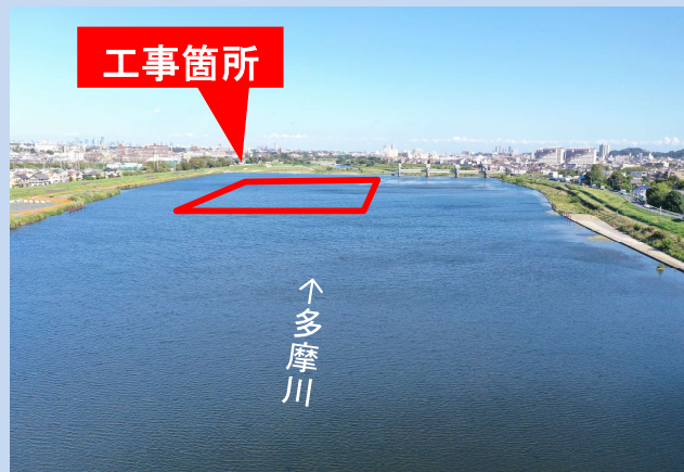
工事着手前 (令和6年9月)
