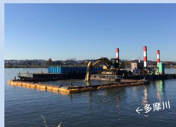
河道を浚渫しています。 (令和6年12月)
