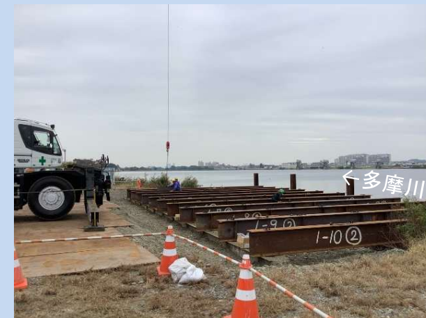
栈橋を設置しています。 (令和6年11月)
