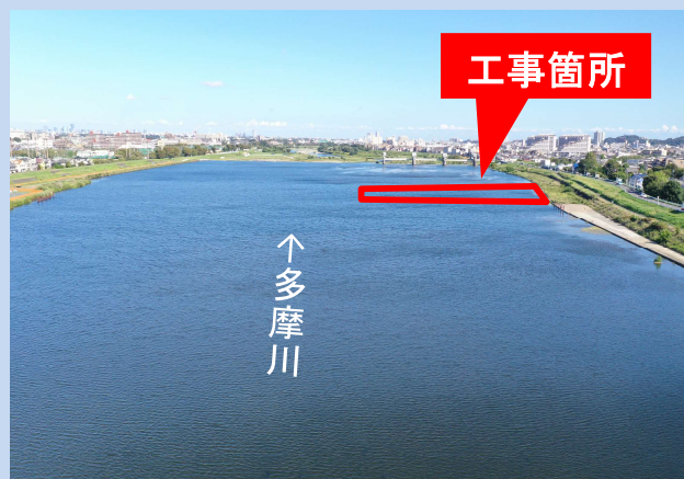
工事着手前 (令和6年9月)
