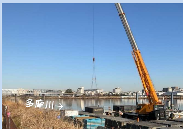
台船を解体しています。 (令和7年2月)
