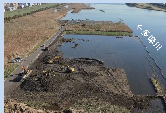
河道を掘削しています。 (令和6年11月)
