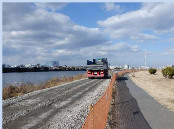
土砂を運搬しています。 (令和7年2月)
