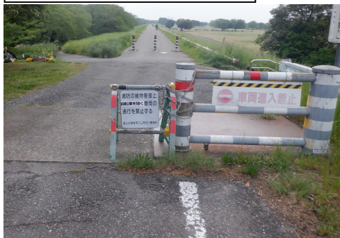
車止めの視認性が悪い
