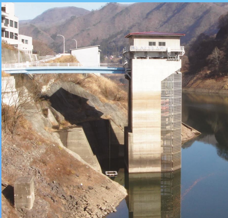
藤原ダム表面取水設備
