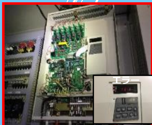
制御盤交換 【インバータ故障】
