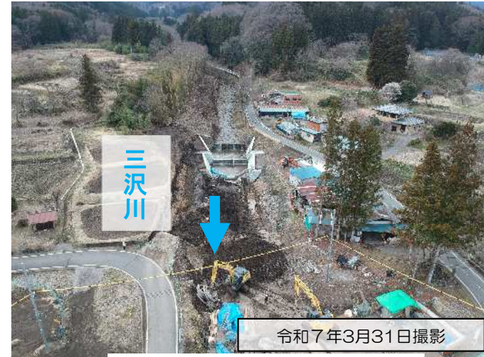
下流側上空から上流方向
