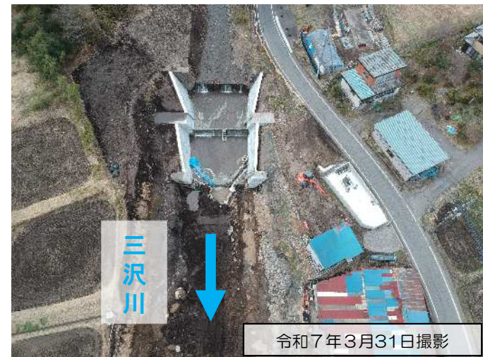
第二床固工下流から上流方向
