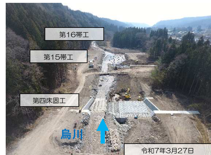
床固工 上流側から
