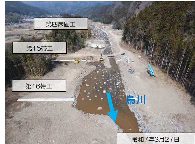
帯工 下流側から
